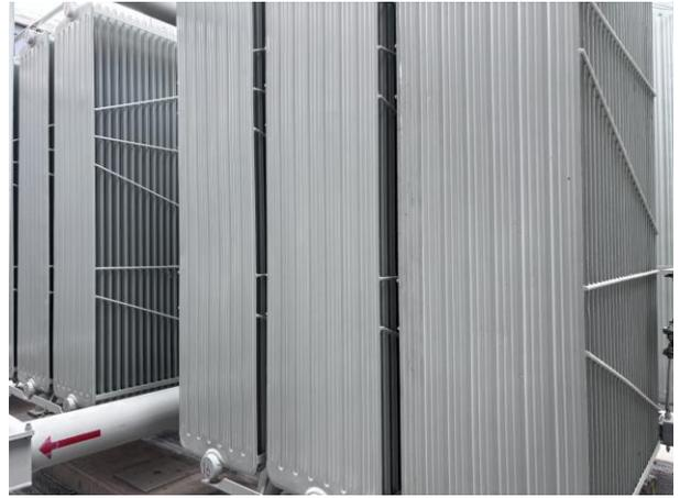
图 4-8 (2) 2#主变压器散热器
