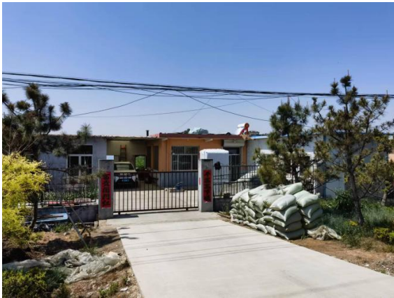
图 2-27 110kV 匡艾乙线 65-17~65-20# 线西 2m 环台东路沿街看护房
