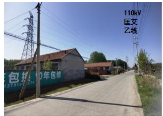
图 2-18 110kV 匡艾乙线 65-02~65-03# 线下路西逢猛张村沿街房
