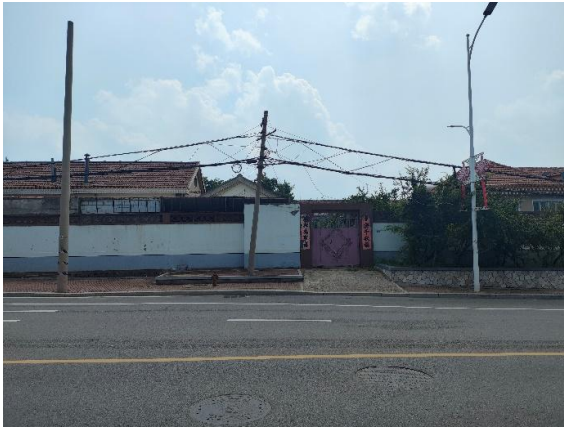
图 2-33 110kV 匡艾乙线 65-35~65-36# 线南 19m 王台路沿街民房
