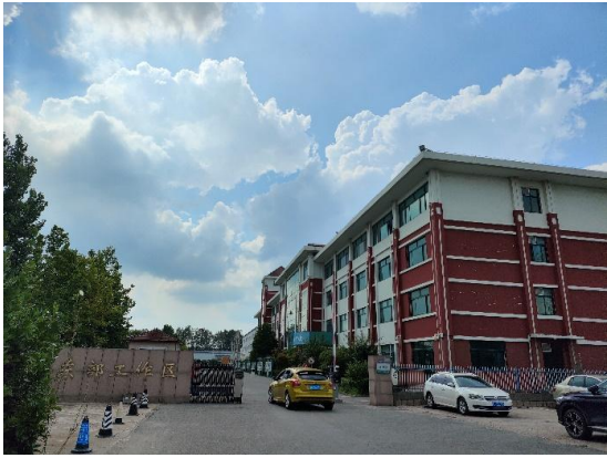
图 2-3 110kV 胶匡线 25-26#线西 28m 胶州供电公司东部工作区
