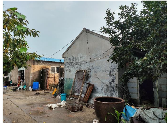
图 2-8 110kV 胶匡线 87-88#线西 15m 姜家村看护房
