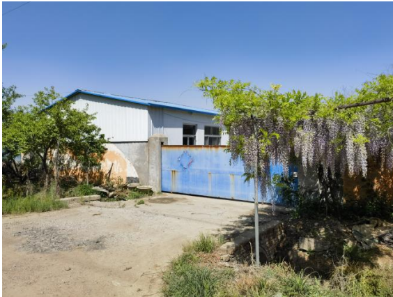
图 2-25 110kV 匡艾乙线 65-13~65-14# 线东 16m 小朱阳村看护房
