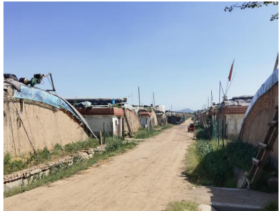
图 2-22 110kV 匡艾乙线 65-10~65-11# 线南 20m 逢猛张村看护房 1
