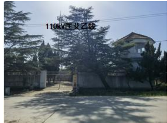
图 2-16 110kV 匡艾乙线 65~65-01#线 西 20m 漕汶河供水管理所
