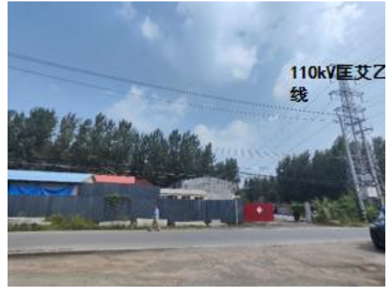
图 2-14 110kV 匡艾乙线 54-55#线下洋 河涯村沿街民房
