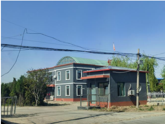
图 2-19 110kV 匡艾乙线 65-06~65-07# 线东 15m 草莓采摘园办公房
