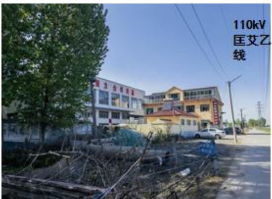
图 2-17 110kV 匡艾乙线 65-01~65-02# 线西 5m 青岛东鑫建材办公室
