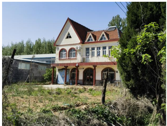
图 2-24 110kV 匡艾乙线 65-12~65-13# 线西 2m 小朱阳村沿街楼房
