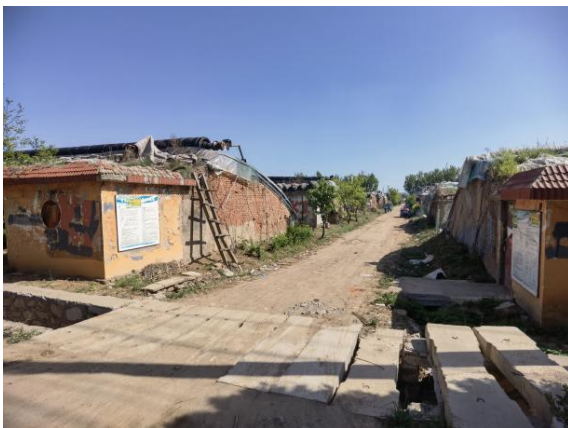
图 2-23 110kV 匡艾乙线 65-11~65-12# 线下逢猛张村看护房 2
