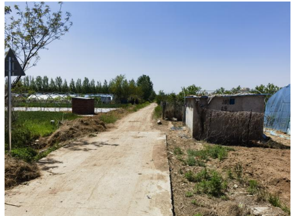
图 2-28 110kV 匡艾乙线 65-20~65-21# 线西 9m 田家窑村大棚看护房
