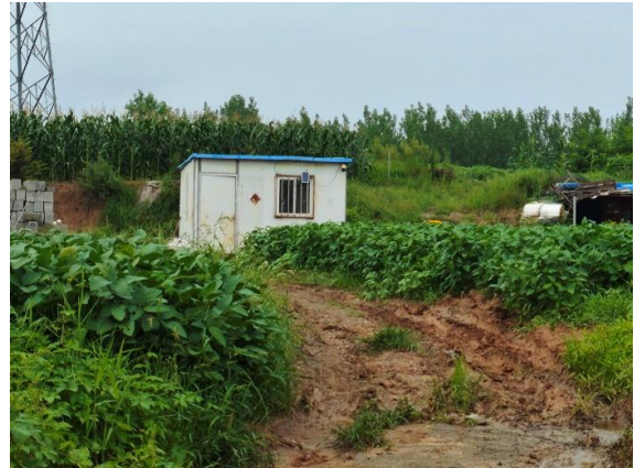
图 2-10 110kV 胶匡线 96-97#线下马家庄村看护房
