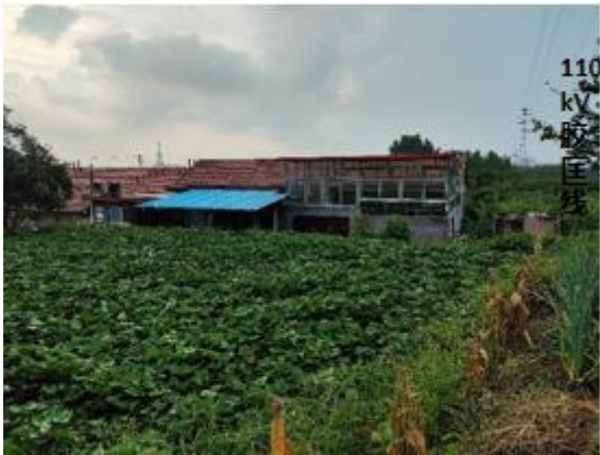
图 2-9 110kV 胶匡线 90-91#线西 10m 大户村民房
