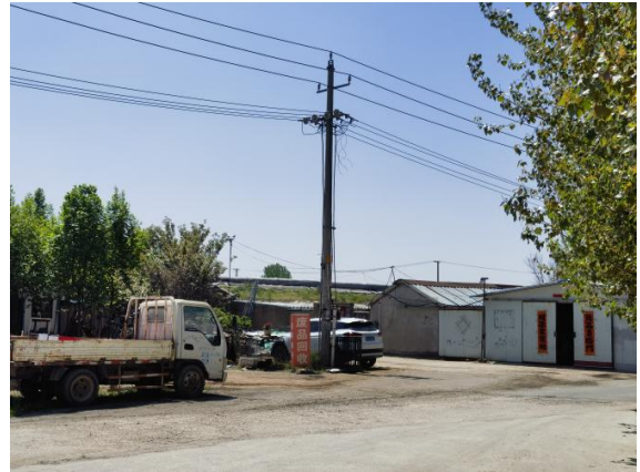
图 2-26 110kV 匡艾乙线 65-16~65-17# 线西 25m 废品回收站附近看护房
