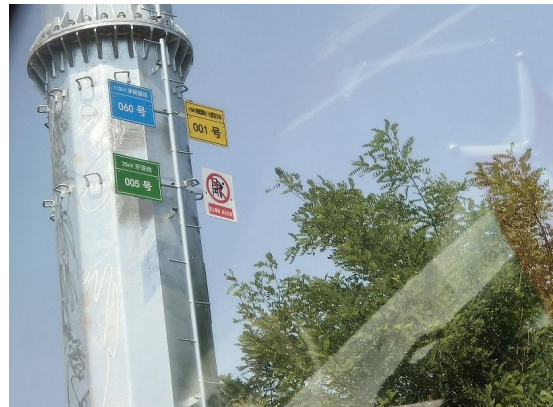
图 6-6 电力警告标志
