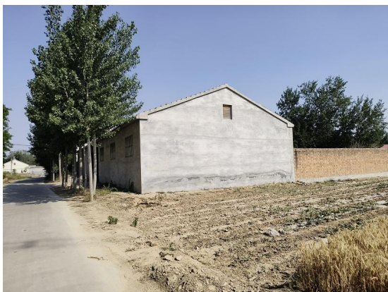
图 2-5 110kV 津历鸿线 50#-51#线东南 29m, 许小庄村西侧民房
