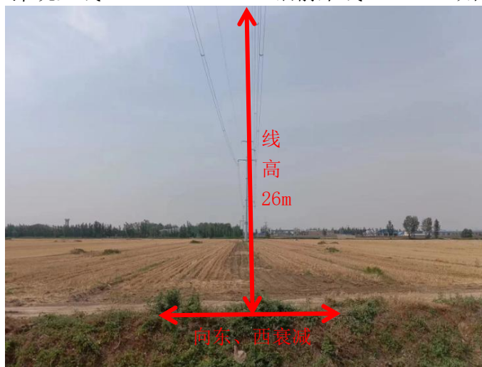
图 7-6 110kV 银箭宋线 57#-58#单回衰减断面
