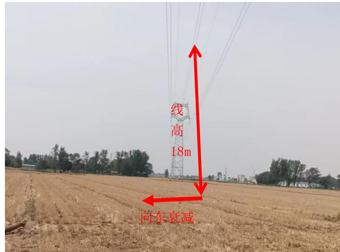
图 7-8 110kV 津历鸿线 52#-53#单回衰减断面
