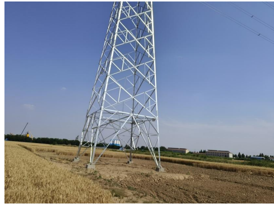
图 6-4 临时道路恢复情况照片
