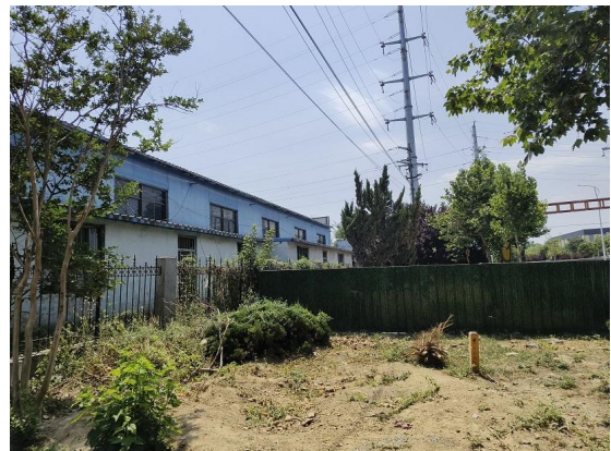
图 2-4 110kV 津砚盟线 59#-60#、110kV 银砚盟线 46#-110kV 银砚盟线 T 会盟站支线 2#线东 10m, 山东卫兴食品饮料公司厂房
