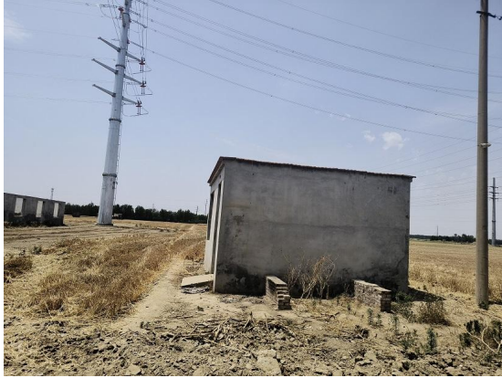
图 2-1 110kV 银箭宋线 21#-22#线北 5m, 李楼村平房
