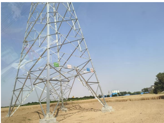
图6-5 塔基恢复情况照片
