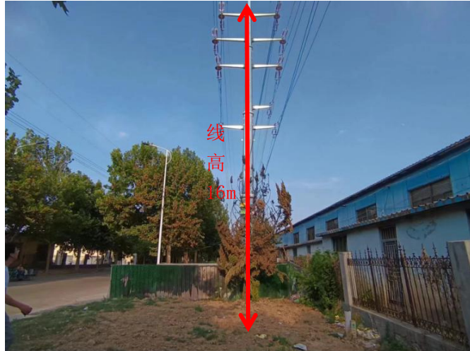
图 7-11 110kV 银砚盟线 46#-47#、110kV 津砚盟线 60#-61#线下
