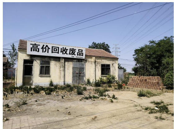
图 2-6 110kV 津砚盟线 40#-41#、110kV 津历鸿线 45#-46#线西北 15m, G308 国道西侧沿街房
