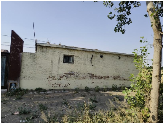
图 2-9 110kV 津箭宋线 T 宋楼站支线 1#线北 17m，厂房
