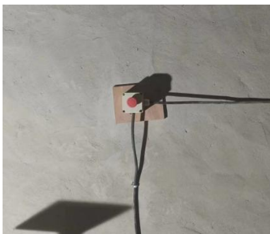
曝光室南侧内墙上急停按钮
