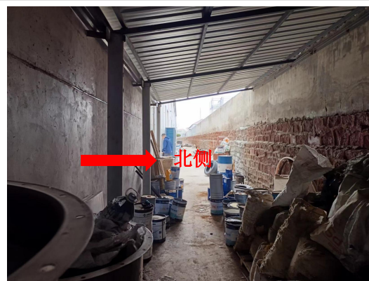
图 2-4 (d) 探伤室北侧
